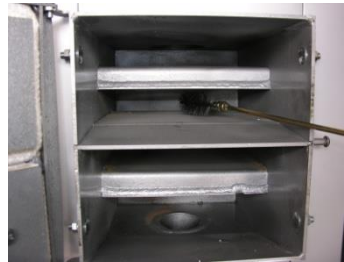
Fot.5. Powierzchnie wymiennika czyścić szczotką lub odkurzaczem.
